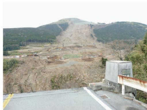
大規模土砂崩れで国道57号・JR豊肥線もろとも阿蘇大橋が崩落した現場 崩壊斜面の上部から安定化工事が始まっている
